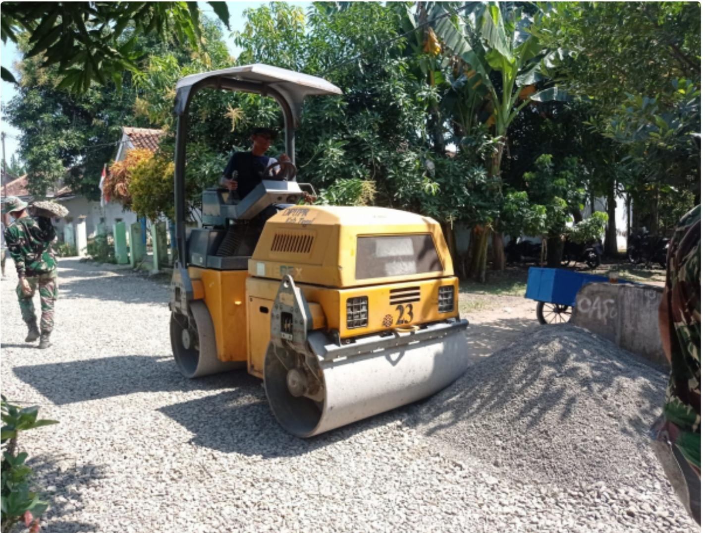
Tegal – Proses pengerjaan pengaspalan jalan Lapen (Lapisan Penetrasi Makadam) sepanjang 1.173 Meter dan lebar 3,5 Meter, melalui TMMD Reguler 114 Kodim 0712 Tegal, dilanjutkan kembali. Senin (1/08/2022).
